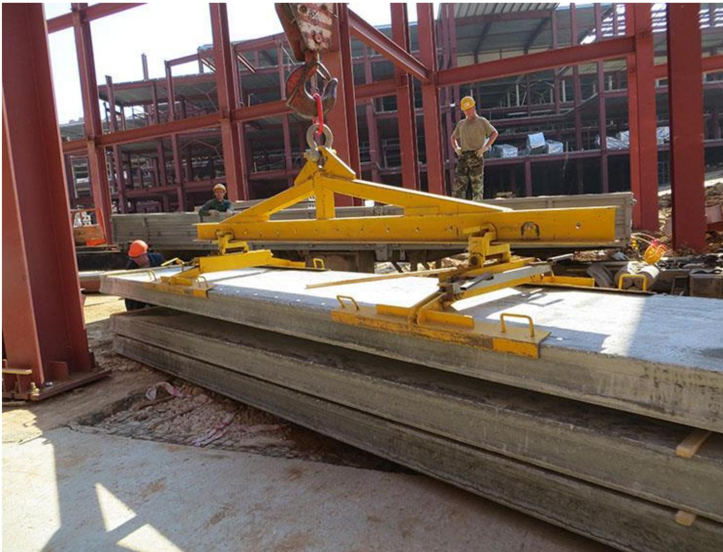
Монтаж плит перекрытия на металлические балки происходит значительно легче, чем на бетон или кирпич.
