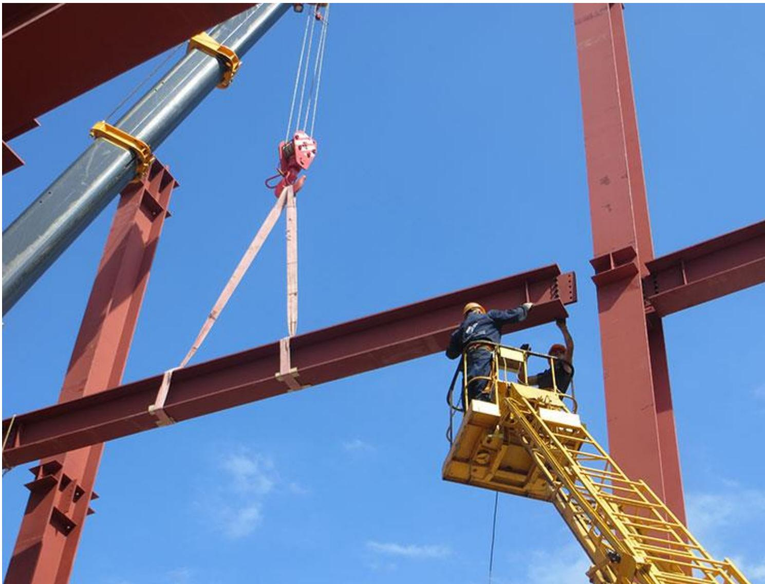
Монтаж металлических балок начинается непосредственно после монтажа металлических колонн.
