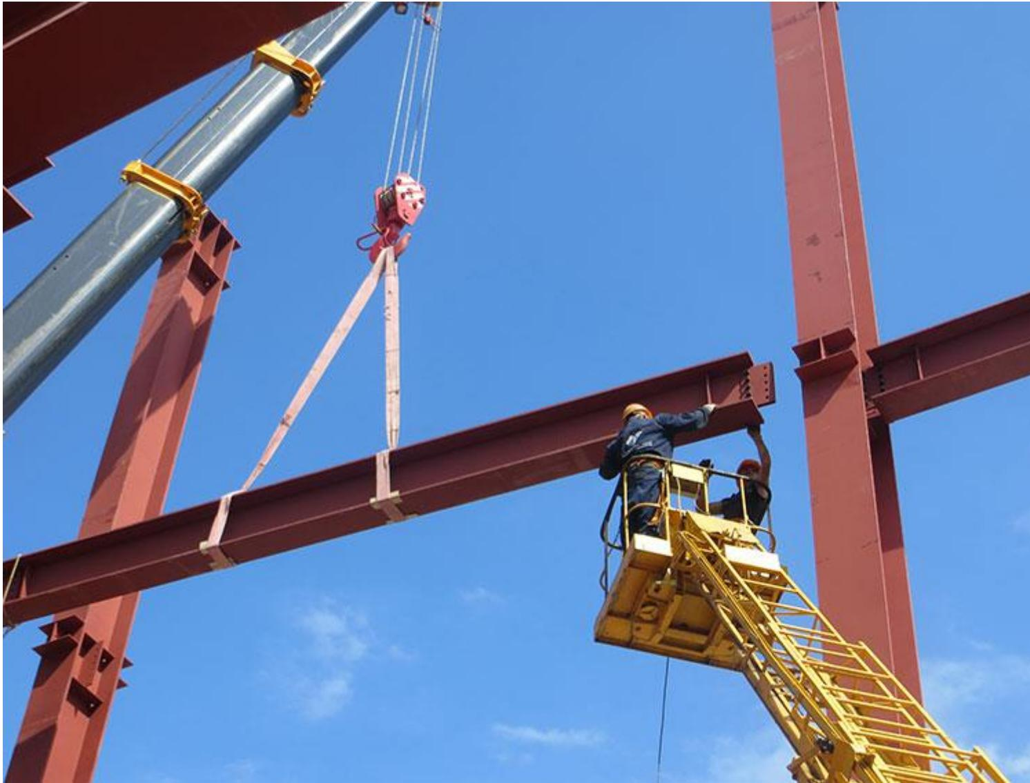
Монтаж металлических балок начинается непосредственно после монтажа металлических колонн. Стропим балку двумя или одним стропом СТП посередине. Бывает, что кромки балки острые и во избежании пореза стропа, необходимо подложить подкладки. В качестве подкладки можно использовать кусок резинового шланга, порезанного вдоль. Поднимаем краном и заводим на место монтажа. Перед тем как начать монтаж металлических балок колонны должны быть уже выставлены по вертикальности с помощью теодолита.
