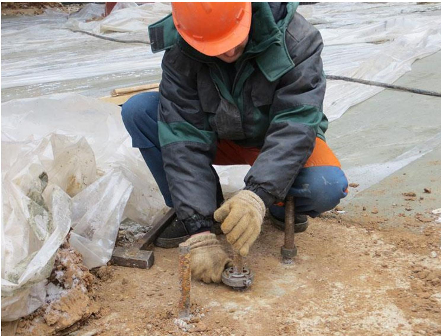
При бетонировании фундамента часто бетонщики не закрывают резьбу анкера, поэтому приходится прогонять резьбу плашкой. Вообще прогнать желательно все резьбы, чтобы не было потом проблем при монтаже колонн. Накручиваем нижние опорные гайки на анкера для колонн и ставим опорные шайбы.
