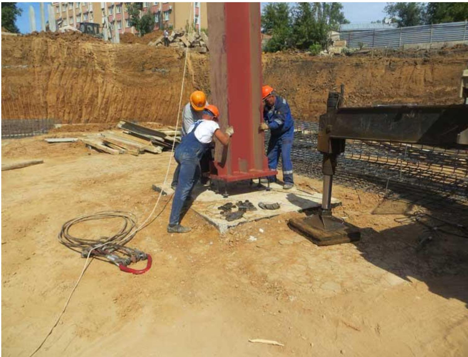
Все готово, начинаем монтаж металлических колонн. Пятку изготовленной металлической колонны располагаем ближе к оси поворота крана. Да, почему должно быть все приготовлено до подъема колонны. У меня два правила, которых придерживаюсь при монтаже.
