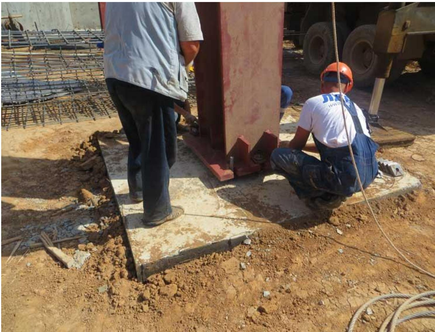
Дальше действуем как по написанному. Поднимаем, заводим на анкера, наживляем гайки, выставляем по осям в проектное положение, затягиваем гайки.
