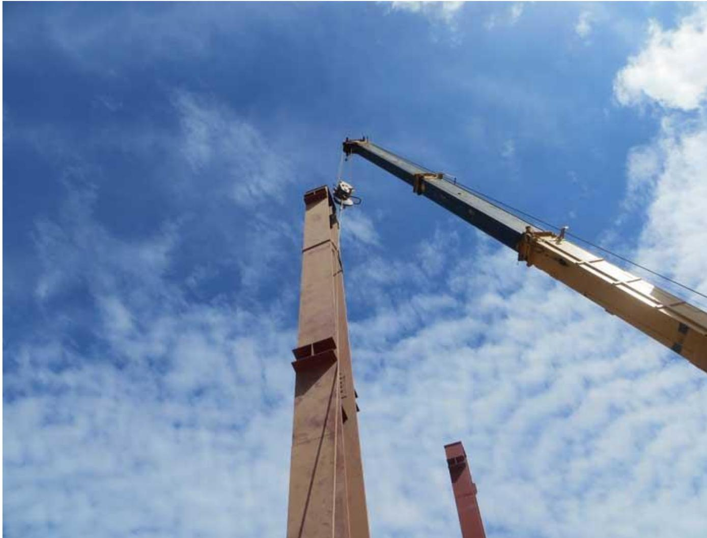
Вертикальность проверяем теодолитом, можно позже, непосредственно перед монтажом металлических балок. Монтаж металлических колонн окончен.
