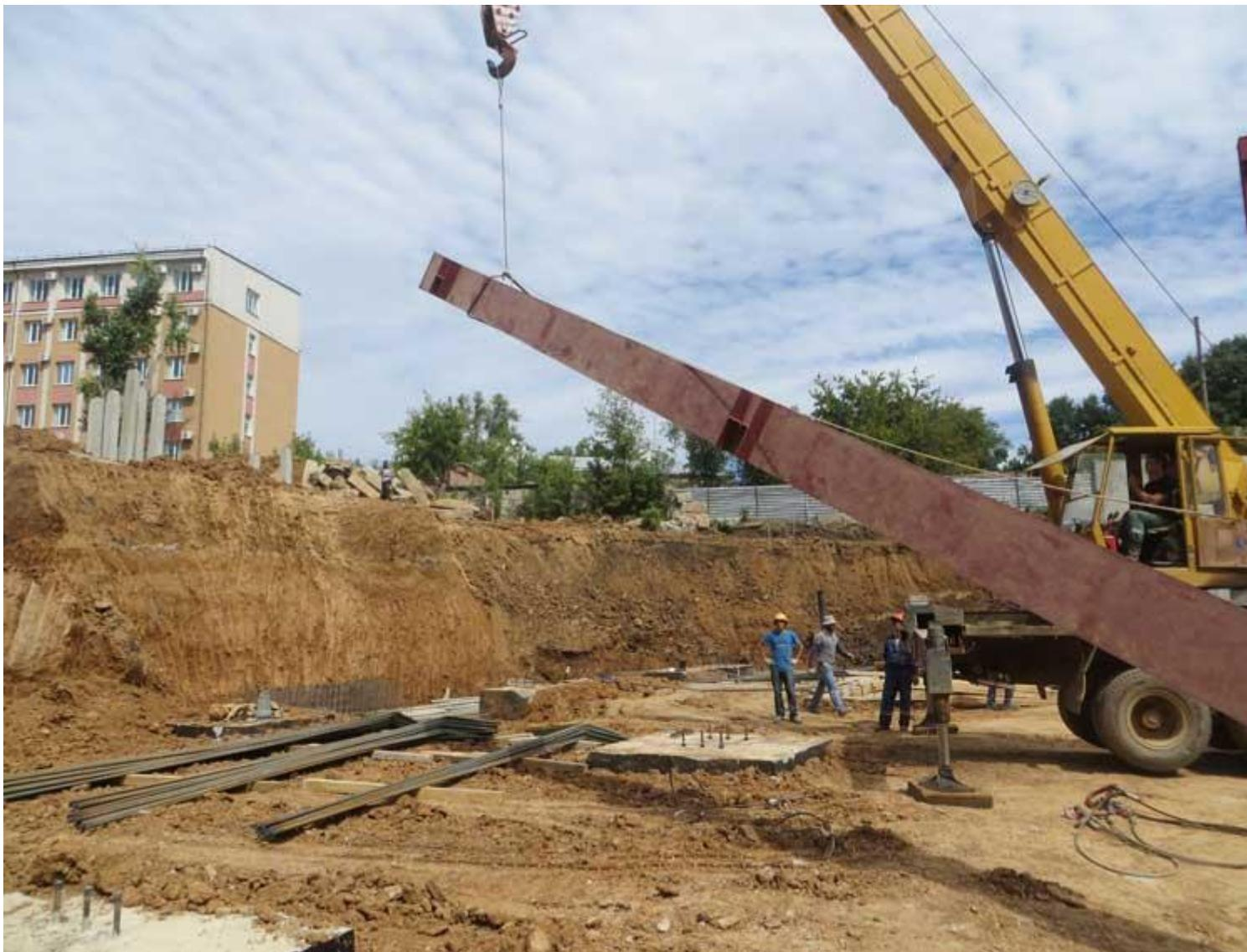
Начинается монтаж металлических колонн, как, впрочем, и железобетонных с разбивки осей. Правило здесь одно. Чем точнее выставишь внизу, тем меньше будет трудностей на высоте.
