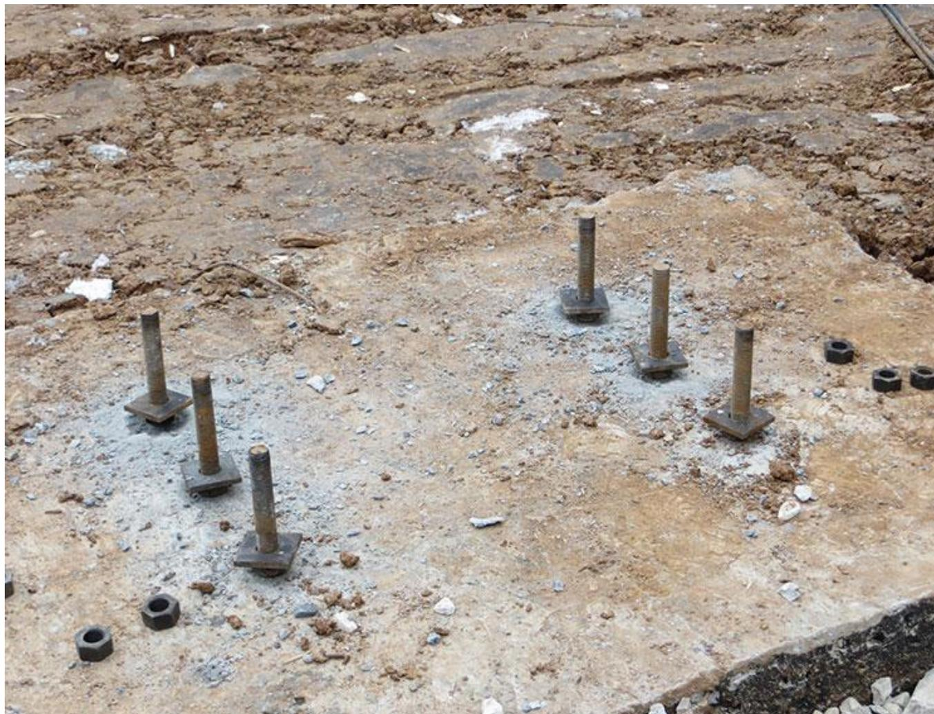
Зачастую подготовка анкера для колонн начинается с исправления косяков бетонщиков.
