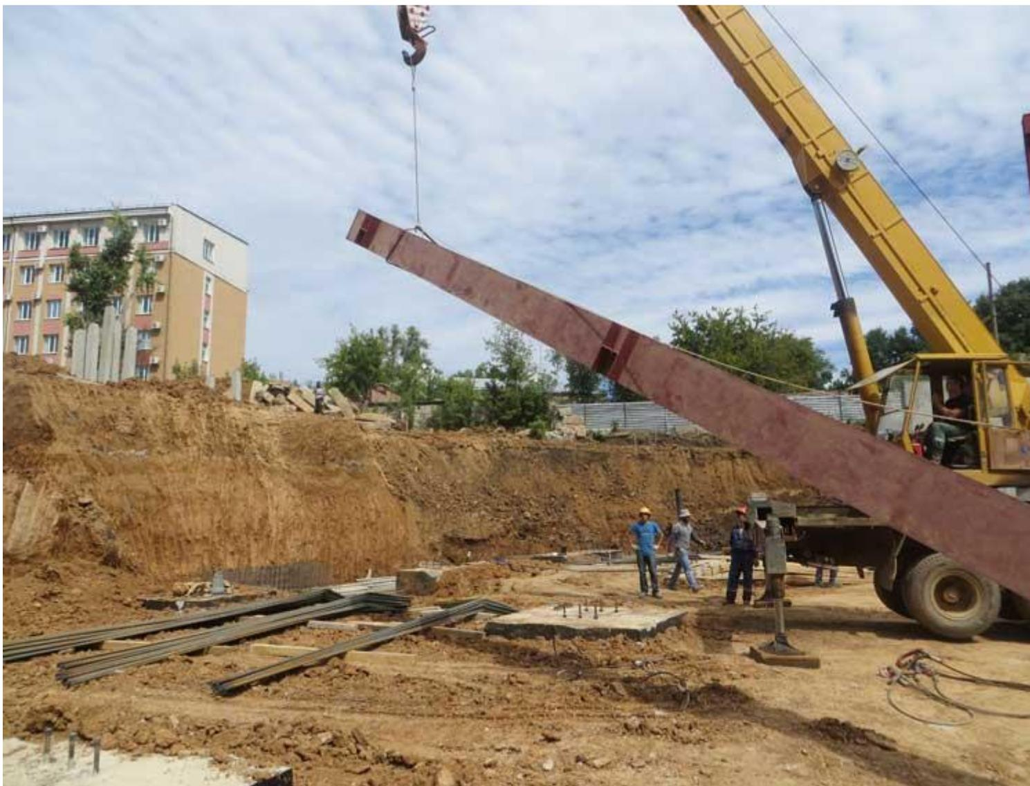
Начинается монтаж металлических колонн, как, впрочем, и железобетонных с разбивки осей.
