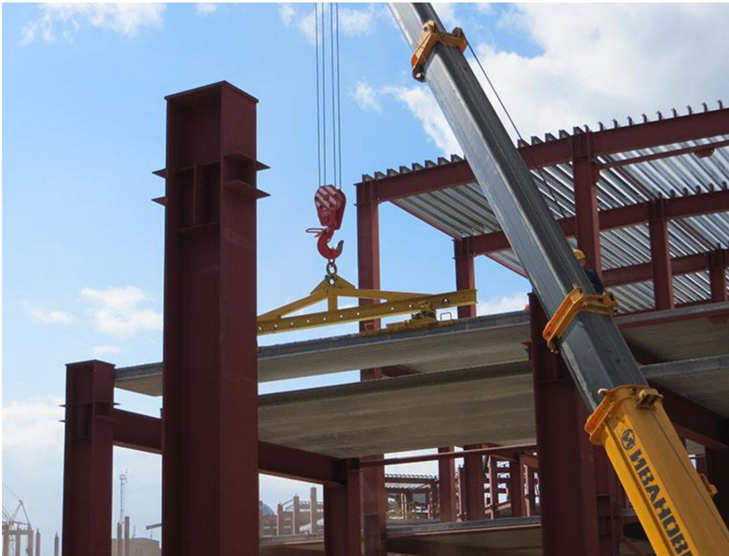
В остальном же монтаж плит перекрытия на металлические балки не так сложен. За смену звено из трех человек монтирует по тридцать плит на 12 метровую отметку.
