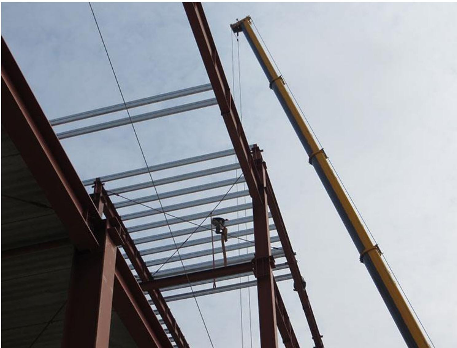
Монтаж прогонов, в данном случае металлических прогонов — завершающий этап монтажа металлоконструкций.
