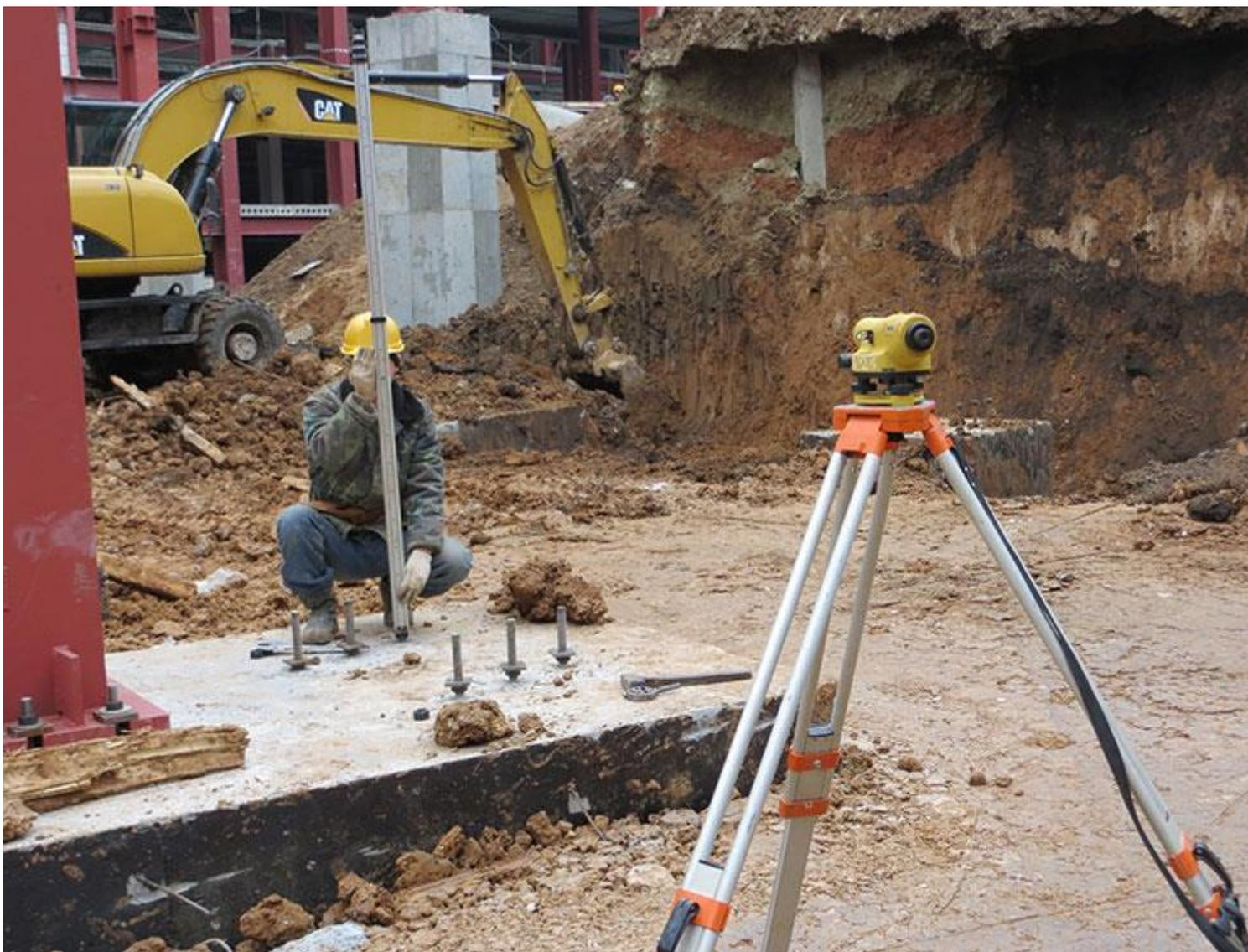
Последний процесс подготовки – выставление высотных отметок пятки колонн по проекту. Можно отстрелять все анкера на одну колонну, либо для ускорения работ отстреливаем один анкер, а остальные выставляем с помощью строительного уровня.
