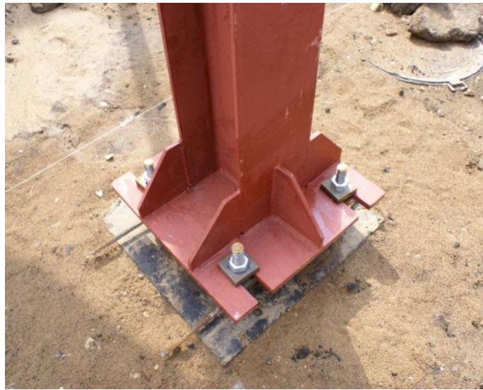
крепление металлических колонн при помощи анкерных болтов
