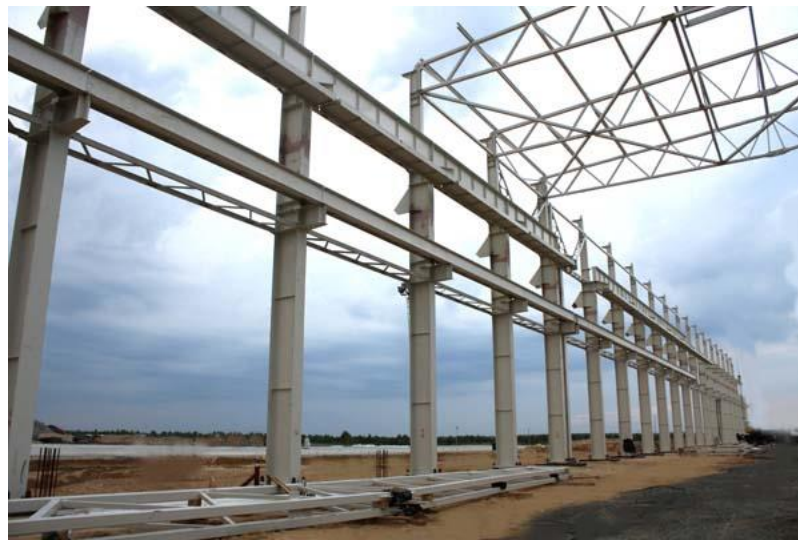
монтаж подкрановых балок
