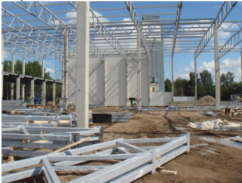
монтаж металлоконструкций при возведении промышленных (складских) помещений
