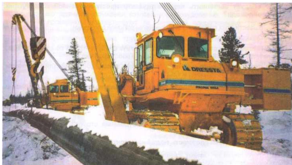
Рис. 67. Укладка трубопровода несколькими кранами-трубоукладчиками
