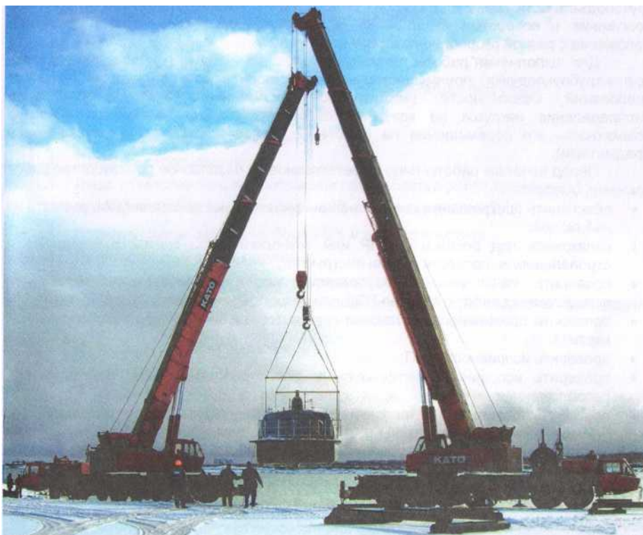
Рис. 56. Подъем теплохода «Заря» двумя кранами KATO NK-1200S
